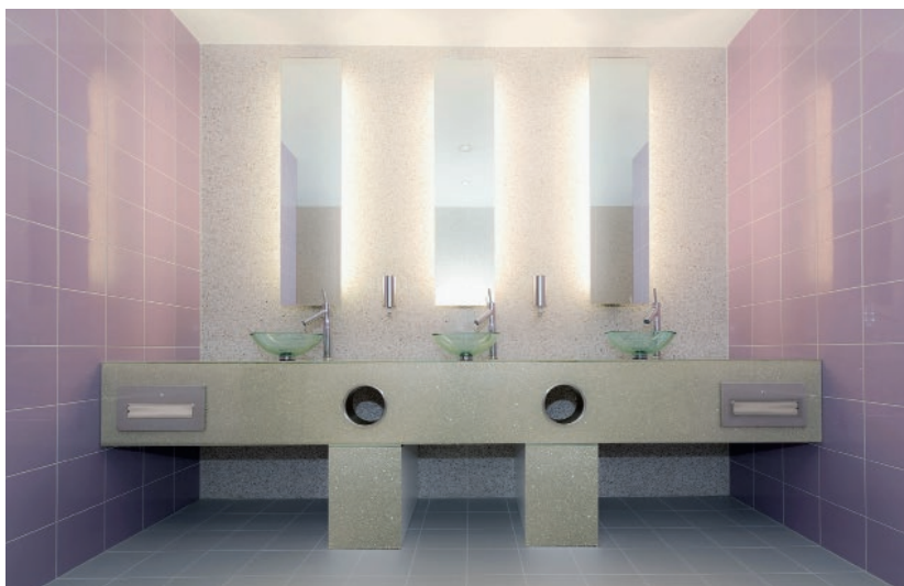
Abb. 4 (Bild unten) Die Installationswand aus poliertem Betonwerkstein in den sanitären Anlagen der Damen
