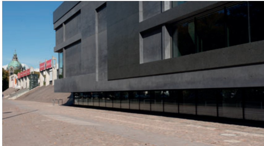
Reliefbänder an der Fassade zeichnen die Ereignisse im Innern des Gebäudes nach.
