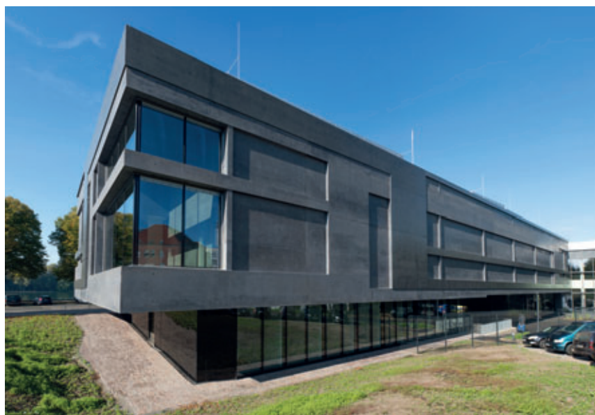
Das Fassadenmaterial Beton erhält durch seine dunkle Färbung fast eine samtige Anmutung.
