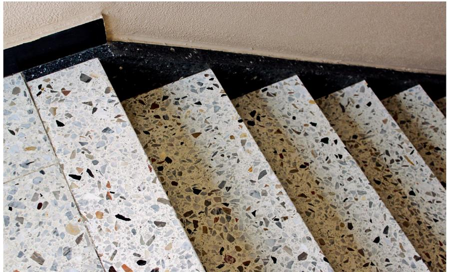
*Abb. 2.11: Ein charakteristisches Beispiel eines Betonwerksteins der 1970er-Jahre zeigt sich in dieser Treppenanlage. Die Verwendung von großen Gesteinskörnungen erzeugte die damals so bevorzugte sog. Bierschinkenoptik.*
