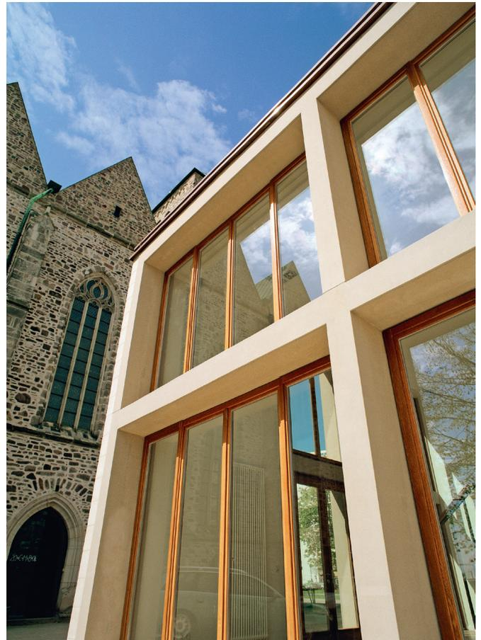
Abb. 2.17: Das Gemeindezentrum der St. Petri Kirche in Magdeburg wird von einer tragenden Stützen-Riegel-Konstruktion aus abgesäuerten Betonfertigteilen geprägt.
