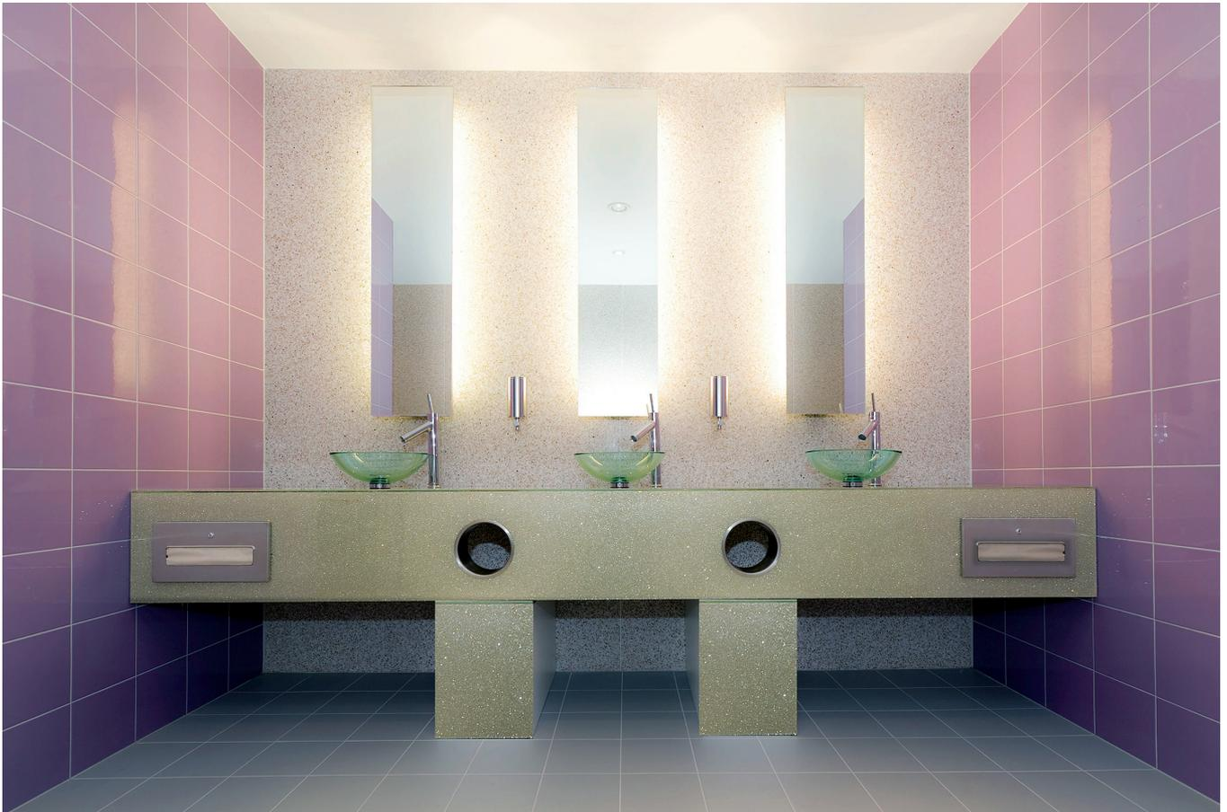
**Abb. 2.10:** Als Spritzschutz in der sanitären Anlage eines Veranstaltungszentrums wurde ein ganz besonderer Betonwerkstein eingesetzt. Seine Wirkung erzielt er durch außergewöhnliche Zuschläge, wie dem Halbedelstein Rosenquarz und einem rosafarbenen Granit, sowie durch seine polierte Oberfläche.
