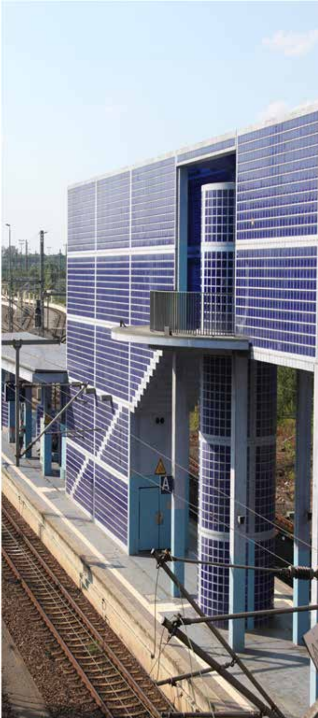
Bild 4 Bahnhof Nordstadt Standort: Engelbosteler Damm, 30167 Hannover Fertigstellung: 1999 Entwurfsverfasser: Hansjörg Göritz Fotografie: Marion von der Heyde
